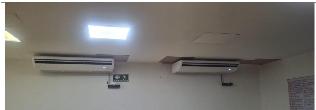
“Casetes” Suministrados e Instalados
